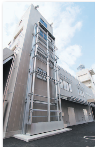
ホース乾燥設備
