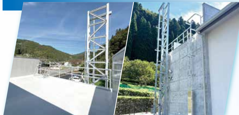
屋上訓練スペース
